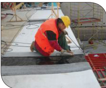
Kontrola jakości i szczelności szwu wysokim napięciem.
